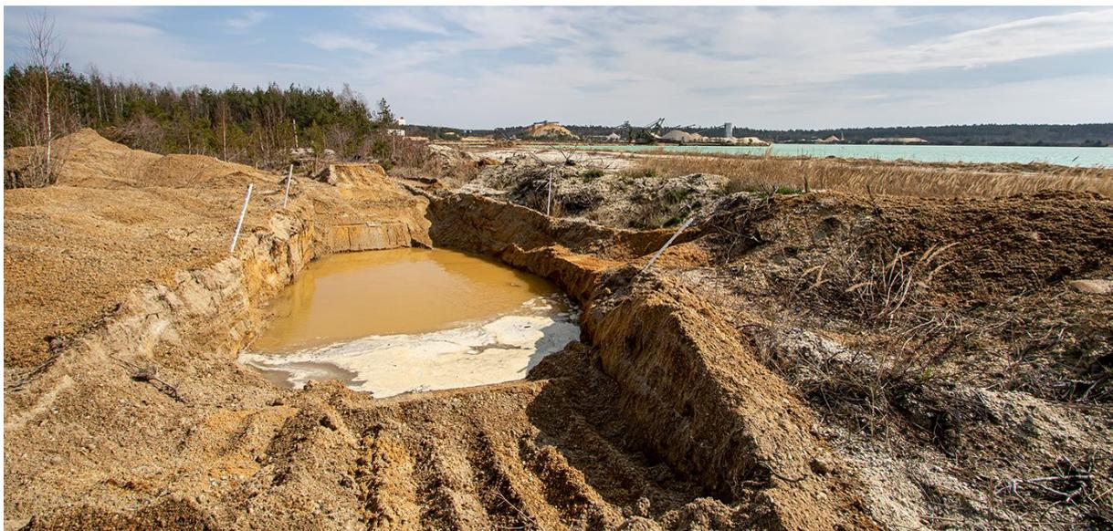
**Abb. 22:** Kleingewässer Nr. 5 direkt nach der Neuanlage mit jeweils zwei steileren und flach zulaufenden Ufern.
