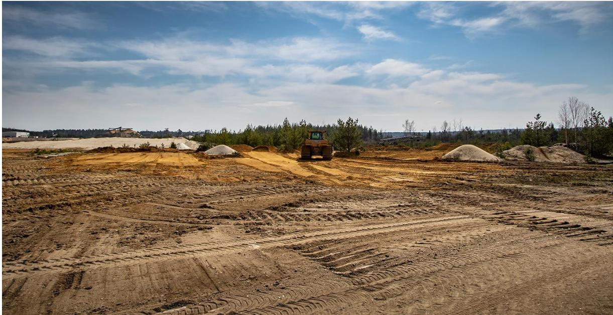
**Abb. 7:** Abschieben der Fläche mittels Raupe, das Material verbleibt als Abgrenzungswall (im Hintergrund).
