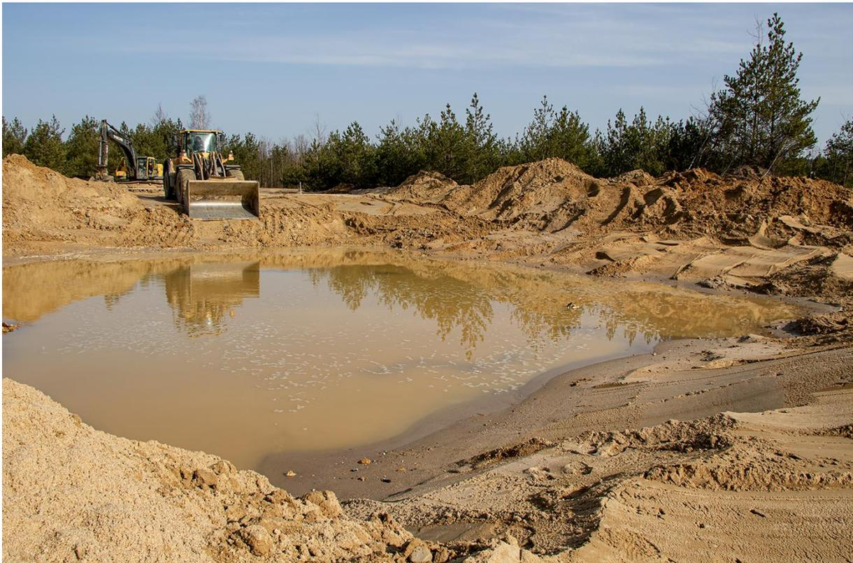
**Abb. 25:** Weitere Gestaltung des Uferbereiches mittels Bagger und Glatziehen mittels des Radladers (Blickrichtung: Norden).
