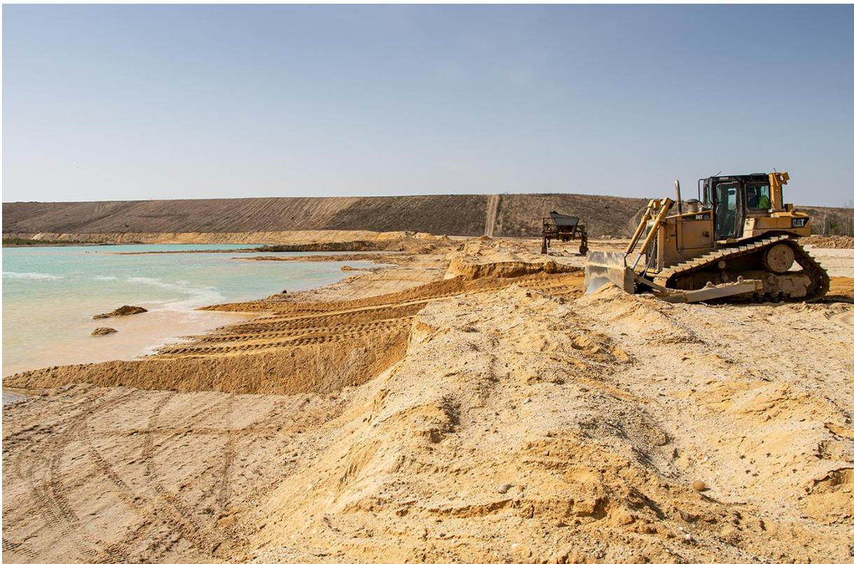
**Abb. 17:** Schieben einer Rampe mittels Radlader und Raupen, um die niedrige Steilböschung für Amphibien überwindbar zu machen (Blickrichtung: Westen).
