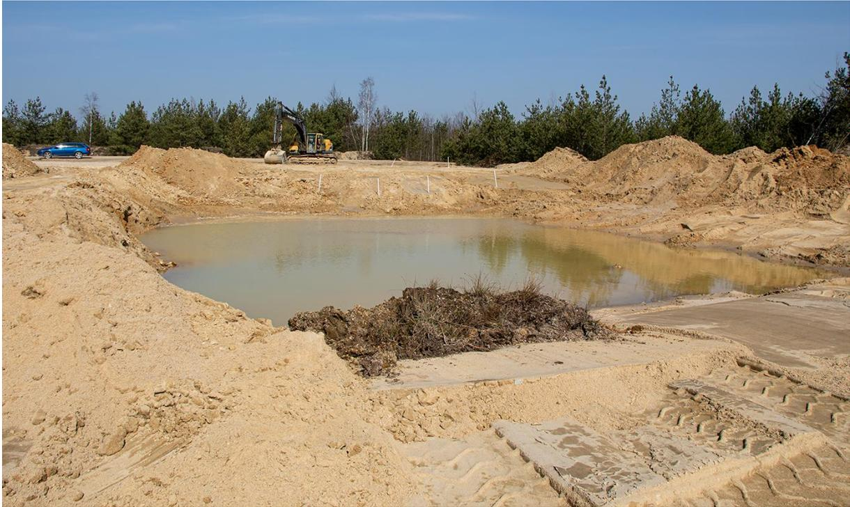
**Abb. 26:** Ausbringung der Bodenschollen mit erstem Bewuchs (vor allem Binsen und Moose).
