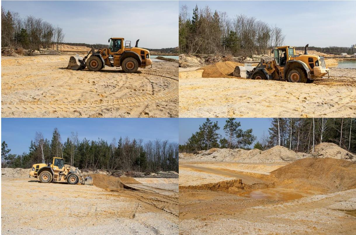
**Abb. 21:** Die Anlage von Kleingewässer Nr. 2 mittels Radlader. Herstellen der gewünschten Tiefe und der Orientierung der Vertiefung (obere Reihe), ein weiteres flaches Ufer wird im rechten Winkel angelegt (untere Reihe). Im letzten Bild erkennt man schon, wie sich das Gewässer füllt (Endzustand siehe nachfolgende Steckbriefe).
